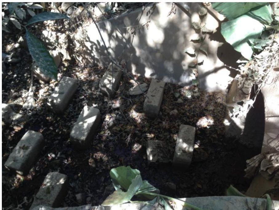
Figura 46: Galeria de concreto com dispositivo de dissipação de energia
