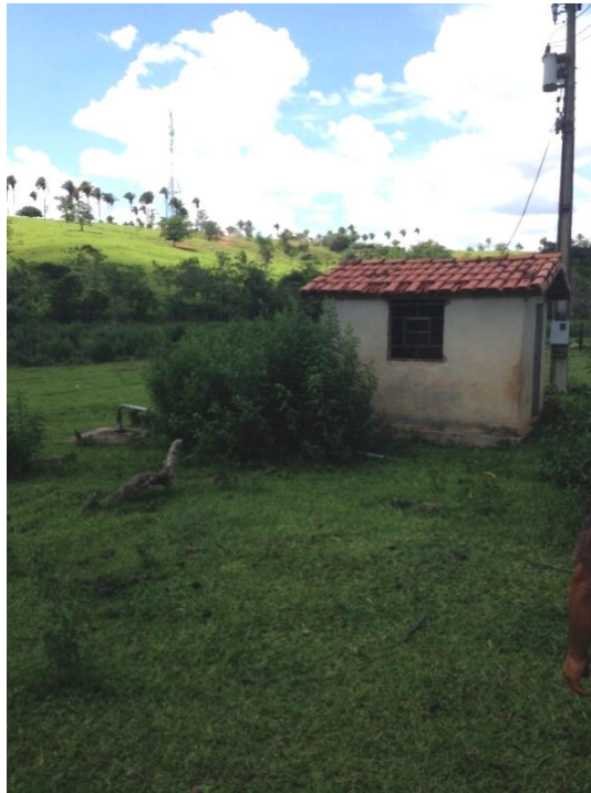
a) Poço artesiano do João Nico
