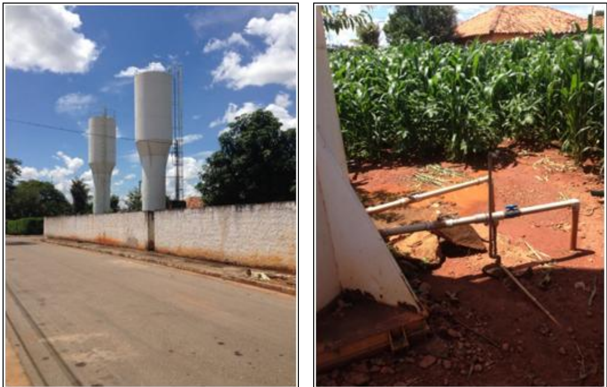
Figura 31: Reservatórios localizados na Rua Antônio Davi Ramos
