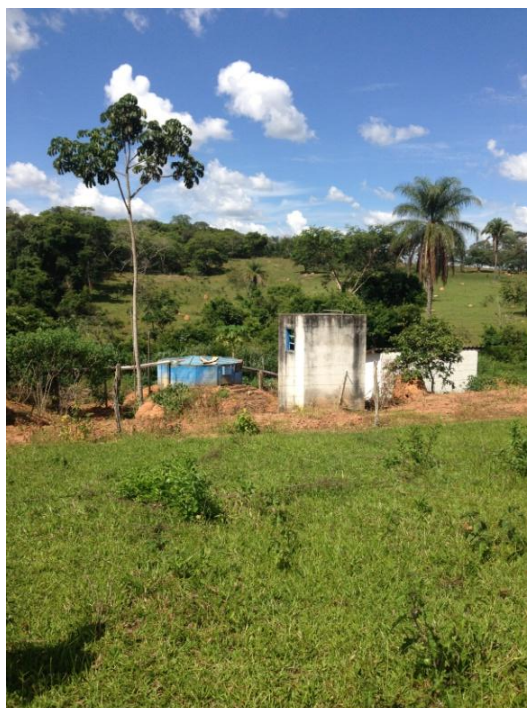
Figura 39: Estação de tratamento de esgoto abandonada
