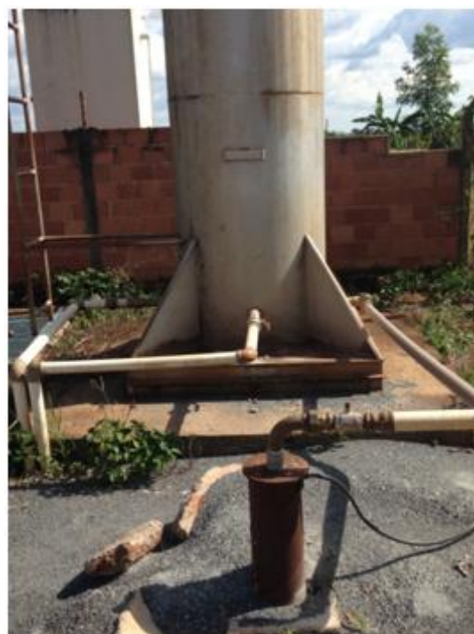
Figura 49: Reservatório e o poço tubular, com detalhe do poço e da base do reservatório
