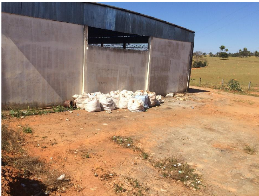
Figura 61: Depósito de recicláveis no pátio do almoxarifado de Douradoquara
