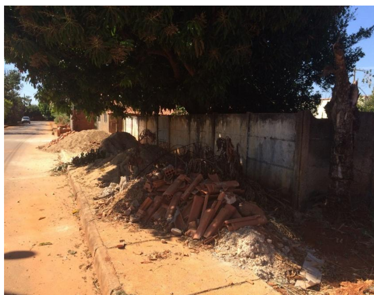
Figura 54: Deposição irregular de resíduos. Agosto, 2015.
