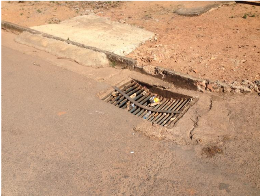
Figura 47: Necessidade de reparos na boca de lobo
