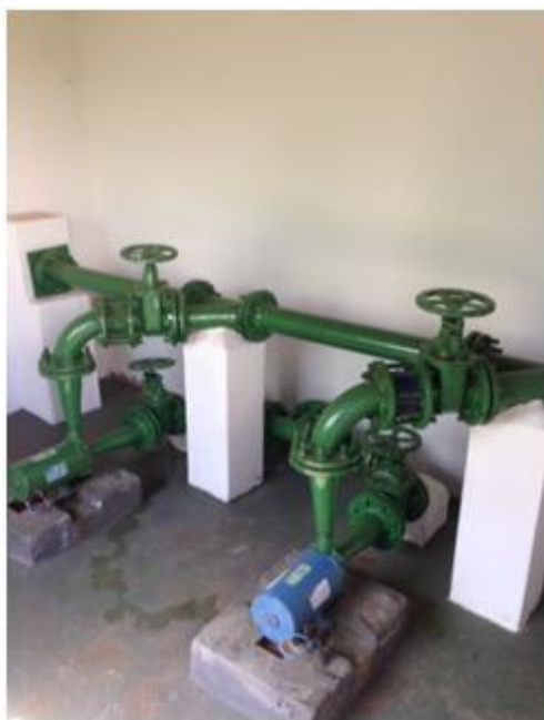
Conjunto de bombas da EAT-02
