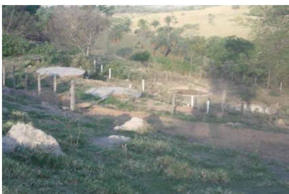
4c) Vista geral da Estação de Tratamento de Esgotos
