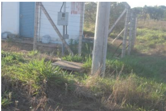
4a) Estação Elevatória de Esgotos (EEE)
