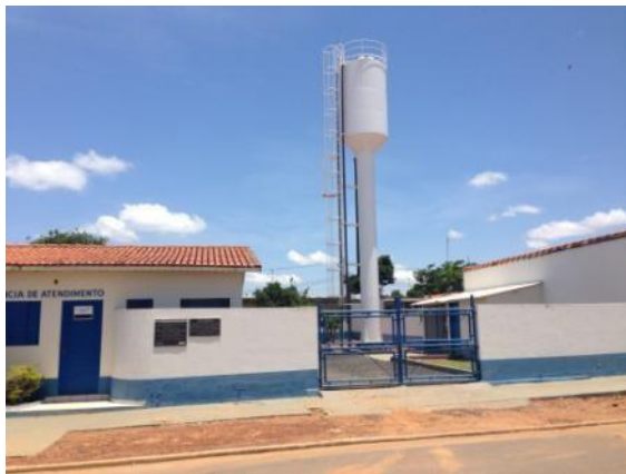
Reservatório elevado que alimenta a rede de distribuição de água
