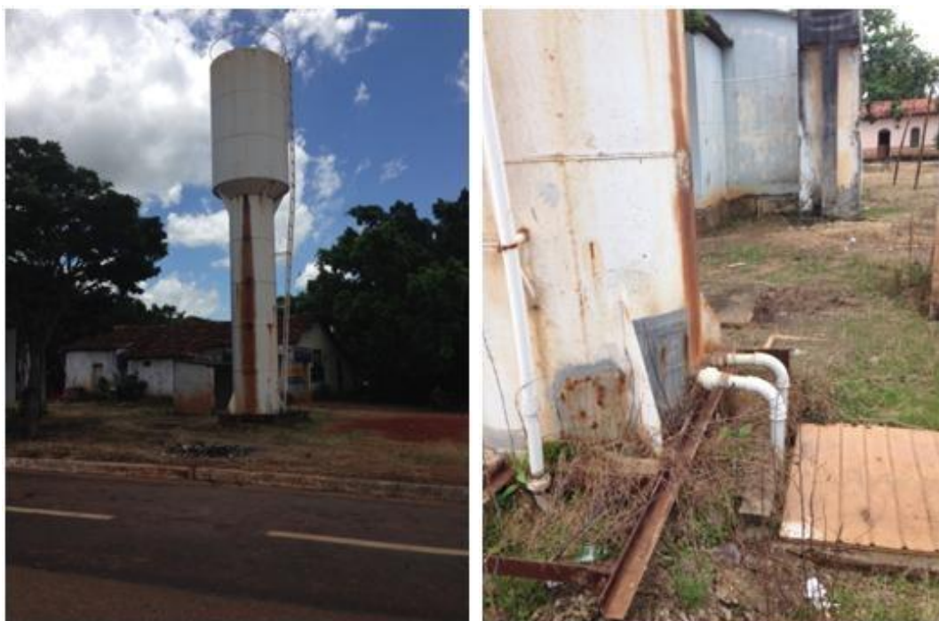
Figura 46: Detalhes do poço artesiano ao lado do reservatório
