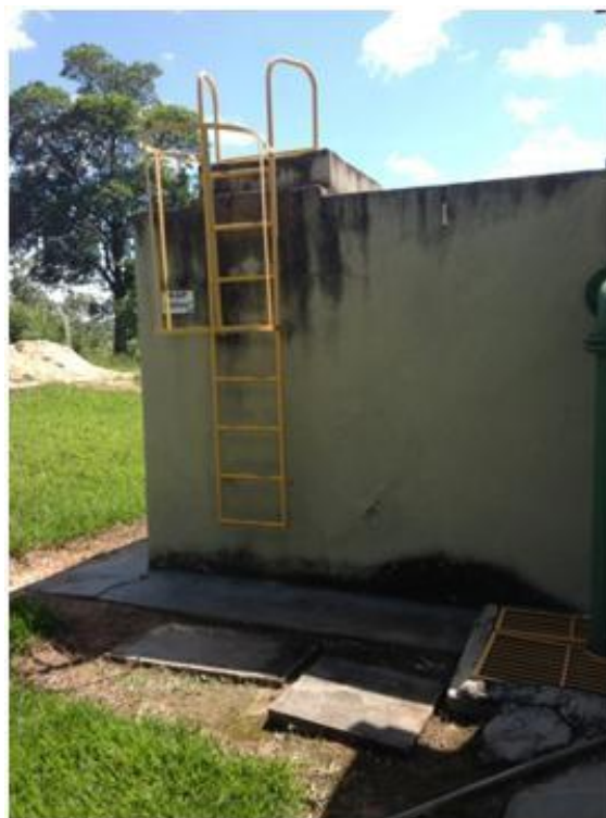
Reservatório da ETA com capacidade de 280 m^3
