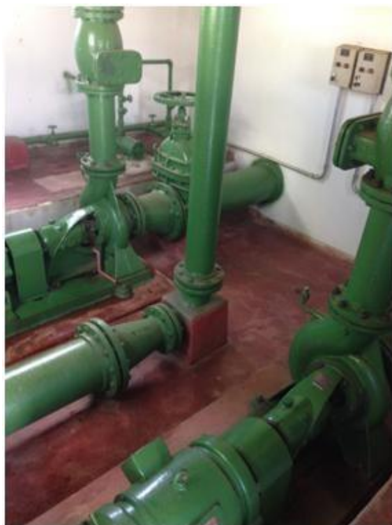
Estação elevatória de lavagem dos filtros
