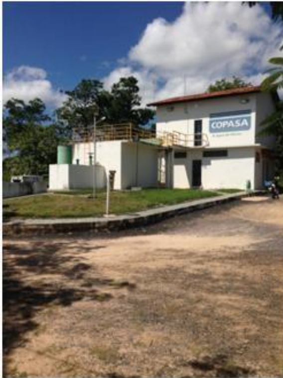
Estação de Tratamento de Água
