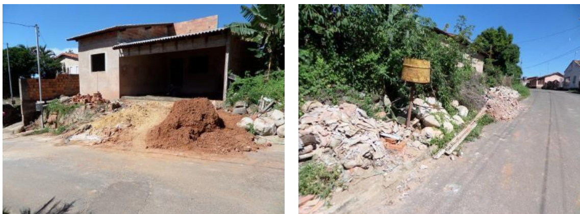
Figura 68: Disposição dos resíduos de construção civil
