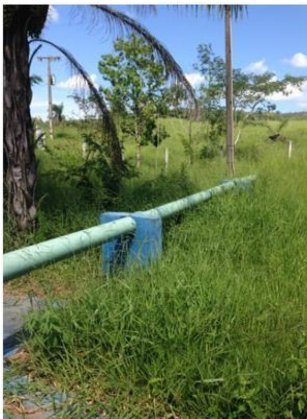
Figura 24: Adutora que alimenta a Estação de Tratamento de Água
