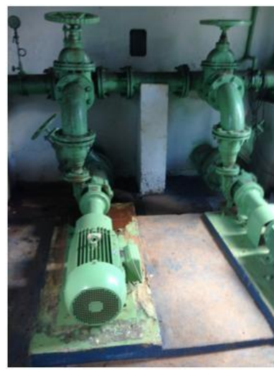
Estação Elevatória - EEAB-02
