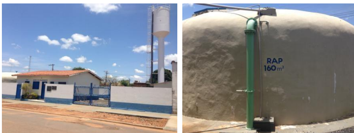
Sistema de reservação de água.
