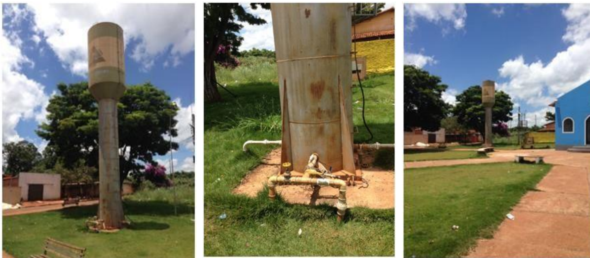
Figura 40: Reservatório e o poço artesiano situados na praça Nossa Senhora da Aparecida
