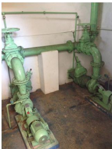
Estação Elevatória - EEAB-01
