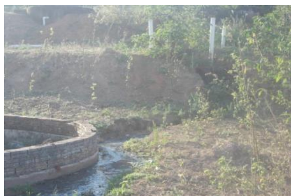
4d) Esgoto a “céu aberto” nas proximidades da ETE
