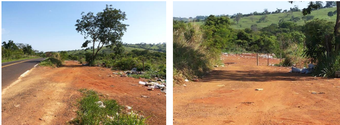
Figura 73: Acesso de entrada na área do aterro controlado
