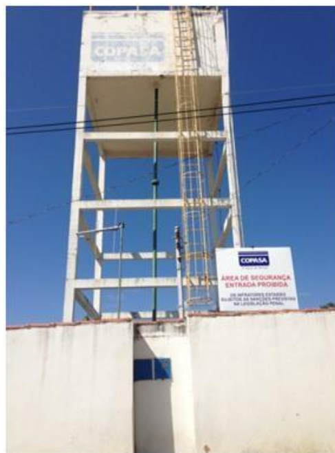
Reservatório elevado de 35m 3 de capacidade
