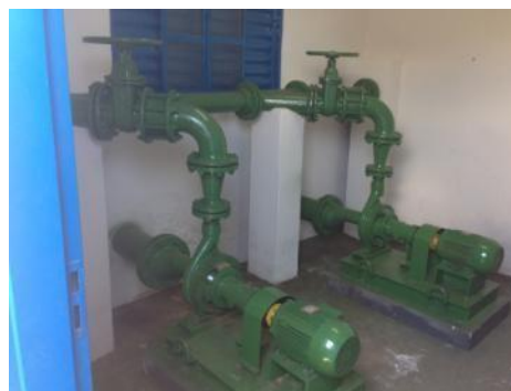
Sistema de bombeamento de água o REL
