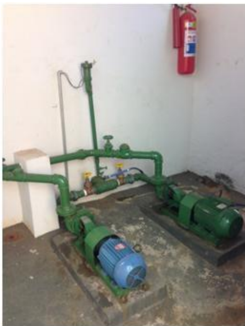
Conjunto de bombas da EAT-01
