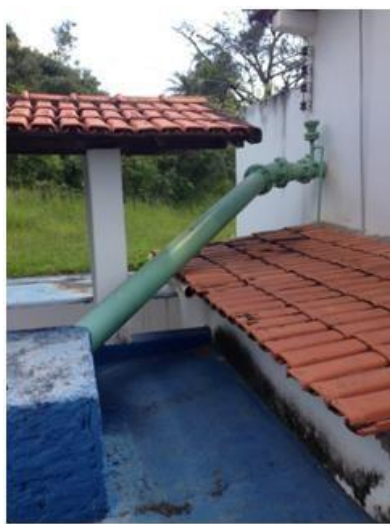
Tubulação de recalque
