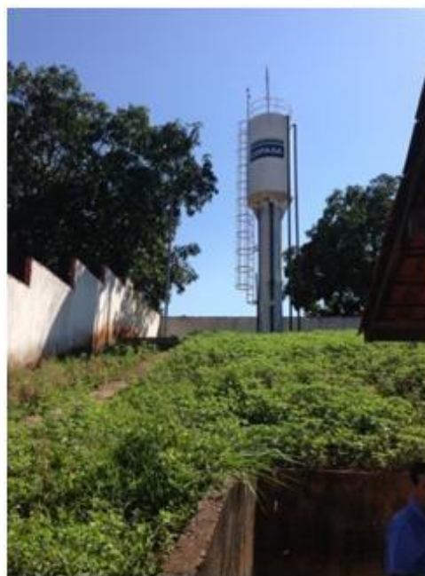
Reservatório elevado de 10m 3 de capacidade
