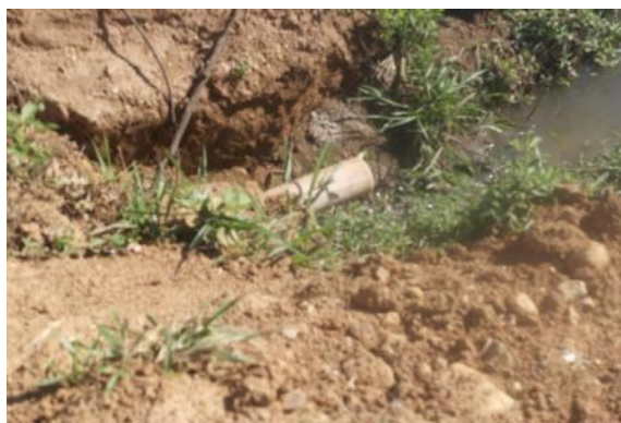
3a) Ponto de lançamento de esgoto no Rio Bagagem
