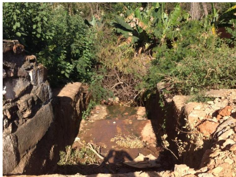
A partir das bocas de lobo necessariamente existe uma galeria para encaminhamento da água até o fundo de vale, entretanto, o posicionamento dos poços de visita (PV) e da rede de drenagem, além dos diâmetros, não são conhecidos. Pode-se deduzir um caminamento provável da rede de água pluvial.
