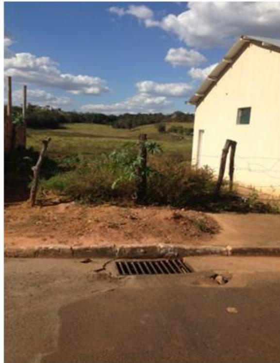
Dentre os vários pontos de descarte das águas pluviais, apenas um possui dissipador de energia que fica localizado no final da Rua Hélio José Ferreira. Essa mesma estrutura deveria ocorrer nos demais pontos de lançamento das águas pluviais (Figura 43).
