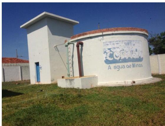
a) Reservatório apoiado (100 m 3 )
