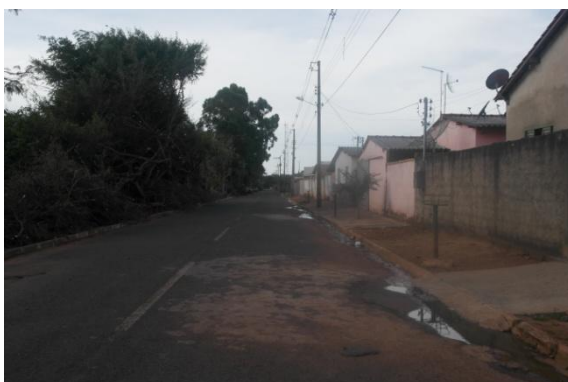
a) Esgoto escoando à “céu aberto”
