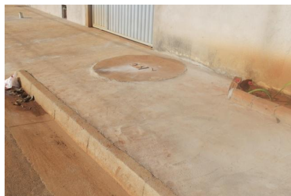
b) Tanque séptico construído em frente a residência
