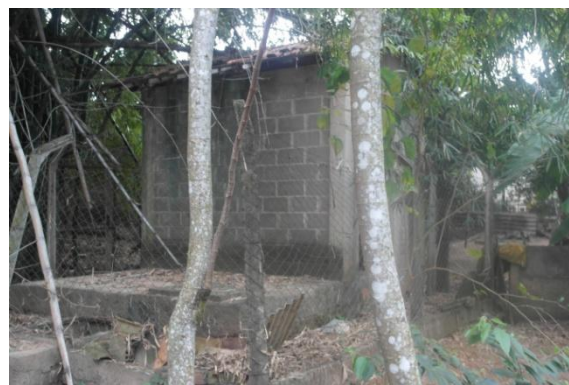
b) Vista da EEE desativada
