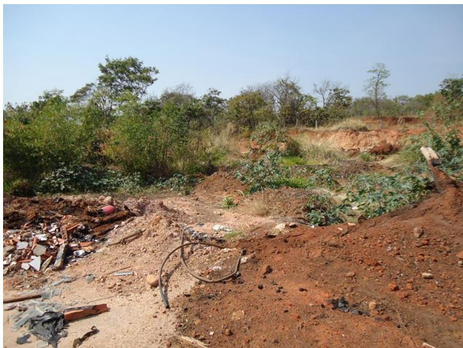
Figura 60: Armazenamento dos resíduos de construção civil e demolição
