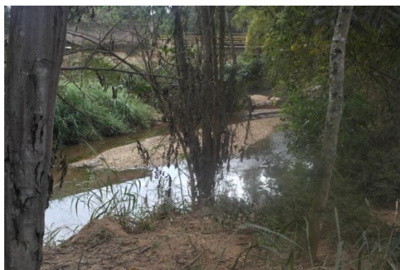
a) Ponto de lançamento de esgoto no Rio das Pedras
