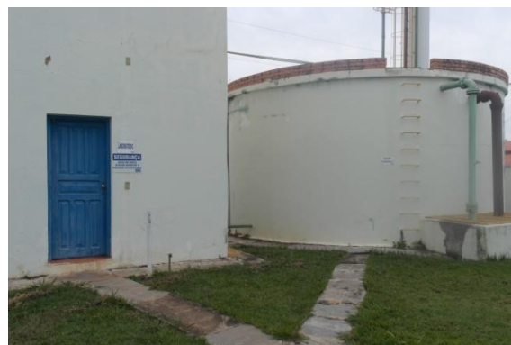
8b) Casa de química e RAP
